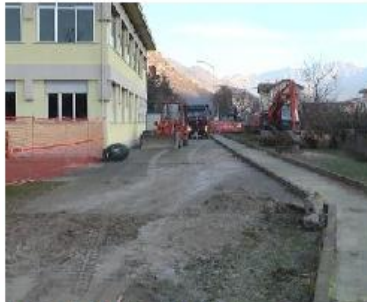
Il cantiere davanti al polo scolastico di Piamborno
